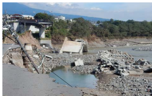
写真 3 東御市海野宿橋の落橋
