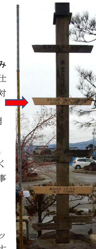
写真 4 千曲川堤防決壊の長野市長沼 妙笑寺境内の千曲川洪水水位標（最上位:戊の満水に次ぐ 2 番目の今回の浸水の高さがすでに設置された）
