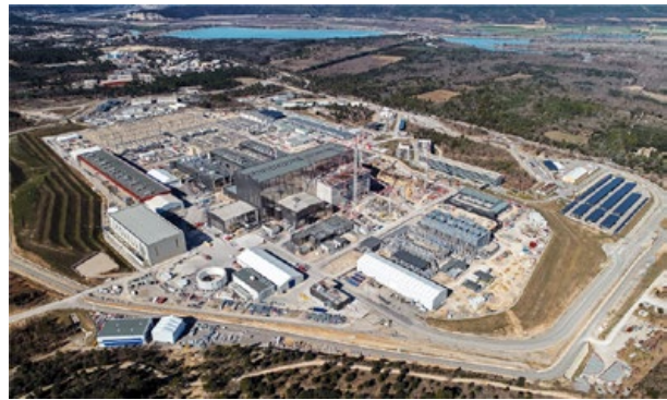
図6 イーター建設サイト (2023年4月) イーター機構提供
