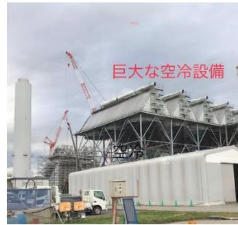
写真2 建設現場(空冷式復水設備)
