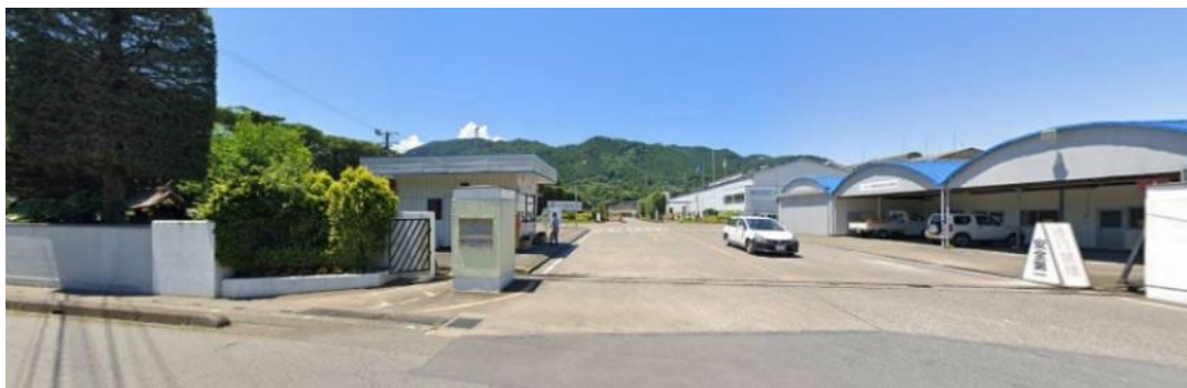
写真1 朝日アグリ（株）関東工場入口
