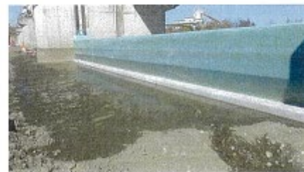
堆積土砂対策 (H28~29)
