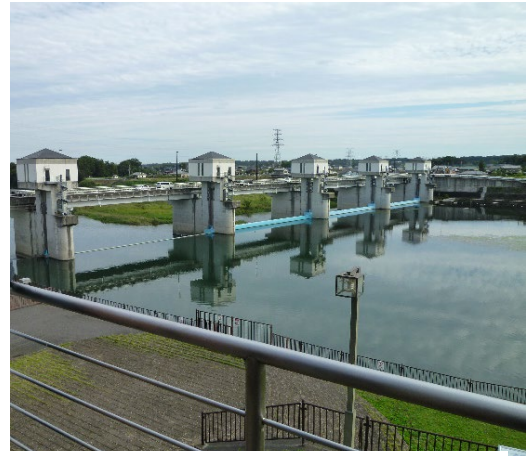
写真9 操作室から見た六堰頭首工
