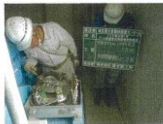
(ゲート、計測設備等点検)
