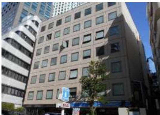
写真1 葺手ビル全景（移転当時） 東京都港区虎ノ門4-1-21
