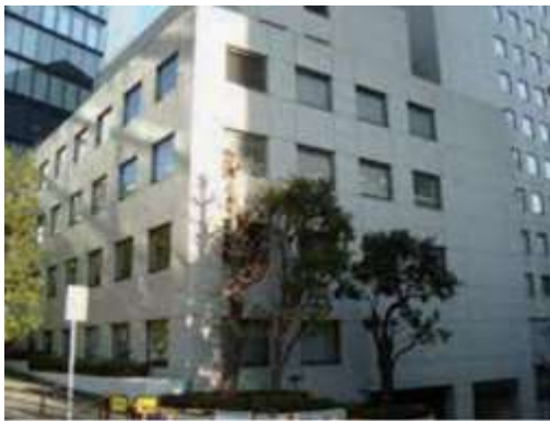
写真3 第二茸手ビル（全景）
